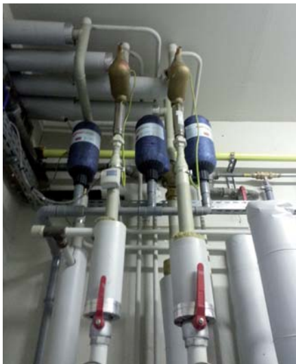
Sur le chantier du Polygone à Strasbourg, au premier plan les conditionneurs et dégazeurs, et à l'arrière, les filtres à brosse sur le retour. Les deux boucles de chauffage doivent être protégées séparément afin de conditionner tout le débit, quitte à ce que les filtres à brosse ne soient pas au niveau du sol.
